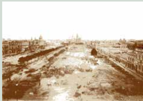
Demoliciones para formar la plaza del Congreso
