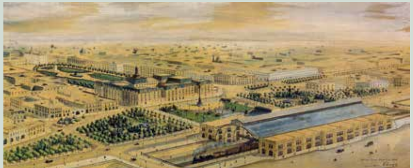
1897. Perspectiva del proyecto de Carlos Thays del borde del espacio público y las terminales ferroviarias lindantes al puerto
