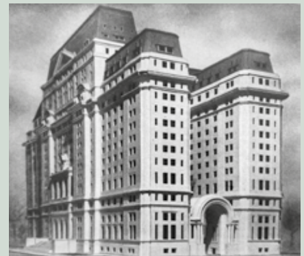
1938. Edificio para el Ministerio de Marina. El edificio proyectado en el Ministerio de Obras Públicas era gemelo del Ministerio de Guerra
